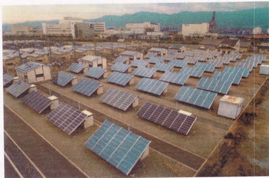
図 3.11 200kW 太陽光発電システム系統連系実験設備 {関西電力(株)六甲新エネルギー実験センター}
