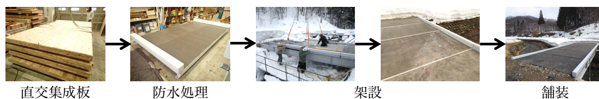
Fig. 20. 防水処理有りのCLT床版の建設過程
