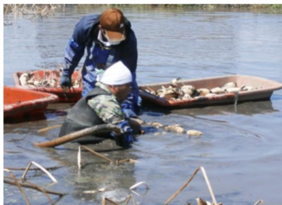
Fig. 1-1 水掘りの様子
