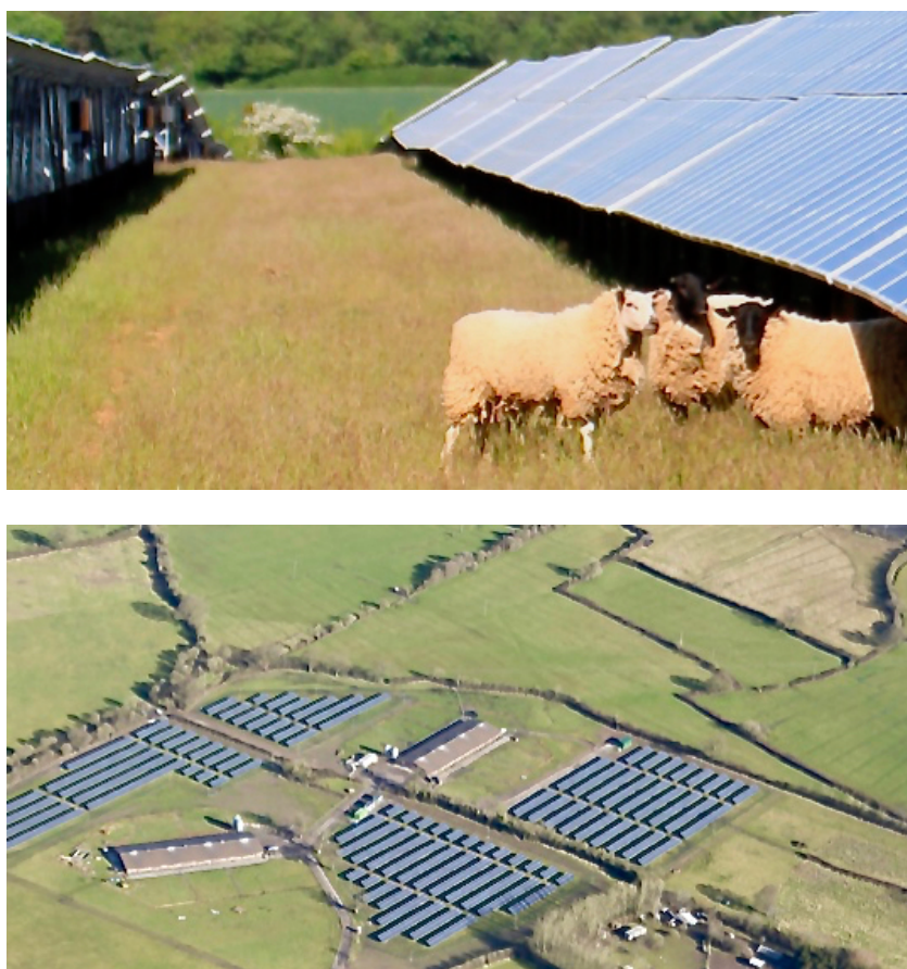
図 4-12 英国 Solar Farm の様子
