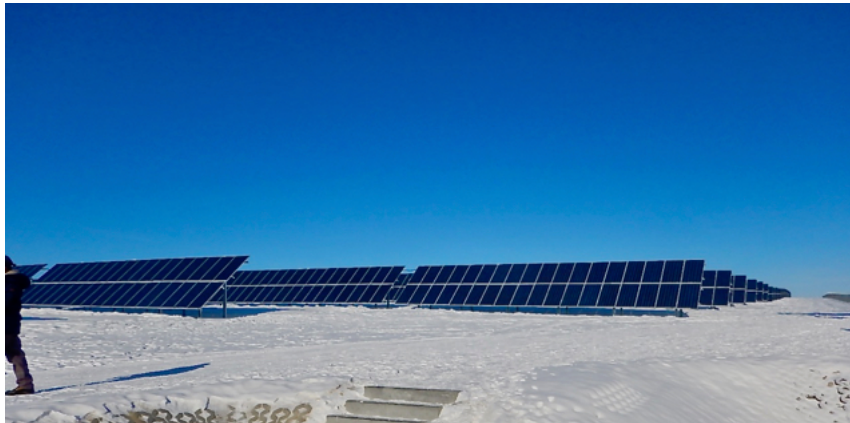
図 4-13 ダルハン 10MW ソーラーシェアリング発電所（モンゴル国）
