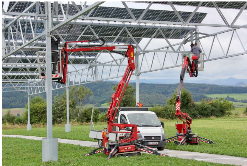
図 4-10 ヘッゲルバッハ（独）の Agrophotovoltaic 実験設備の様子 Source: University of Hohenheim, 2017, APV-RESOLA Project
