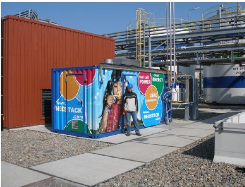
図 6 AkzoNobel のソーダ電解工場に導入された純水素燃料電池 (70kW) の外観写真[14]
