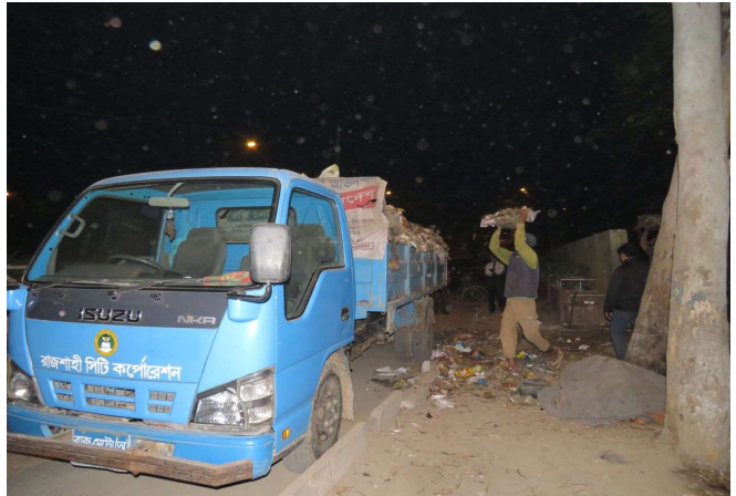
写真 4.2 RCC による第二次ごみ集積場から最終処分場までのごみの運搬
