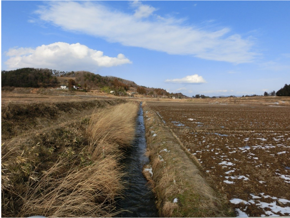
Fig. 3.16 排水路 (Fig. 3.13 中③) (2013年2月15日撮影)
