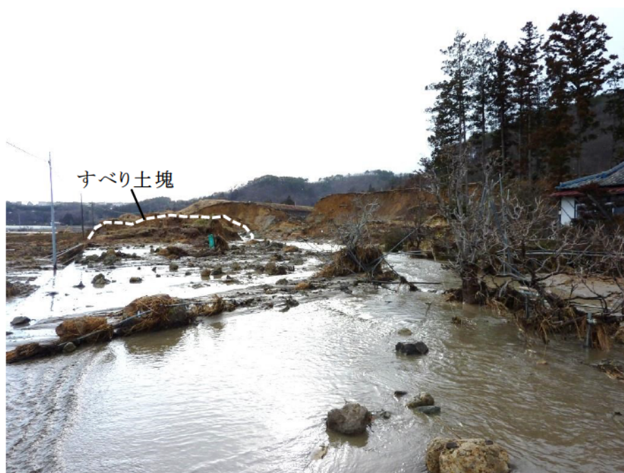
Fig. 3.11 決壊点（本宮市提供；2011年3月11日撮影）
