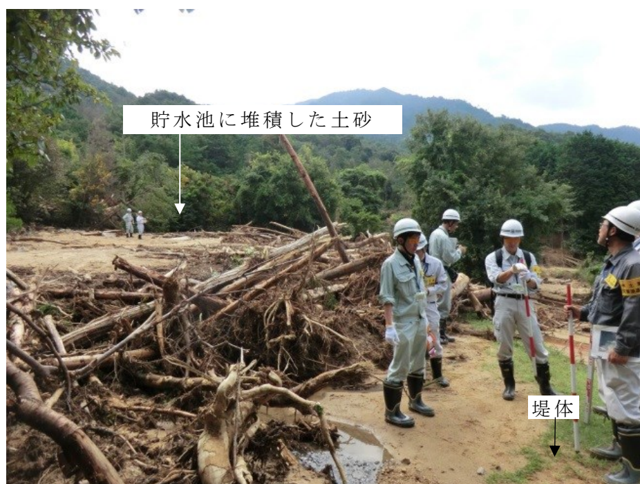
Fig. 7.1 堤体天端まで土砂が堆積したため池
