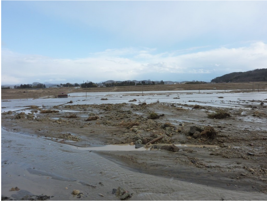
Fig. 3.12 堤体直下農地の土砂堆積① (本宮市提供；2011年3月11日撮影)
