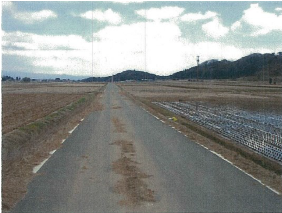
Fig. 3.5 堆積物(2) 農道路面上に稲わら等が堆積 (提供：須賀川市，2011年3月24日撮影)
