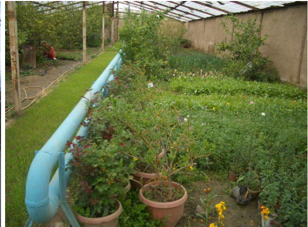
温室中は、中心に設置されたパイプヒーターによって温められる
