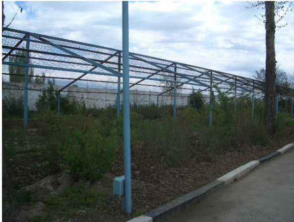
旧ソ連時代に建設された温室の枠組みが多く残る
