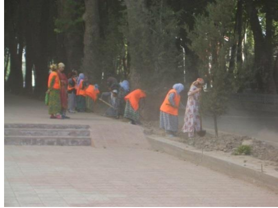
写真-5-2 ルダキ道路で植栽をする作業者 (2011. 6. 14 撮影)
